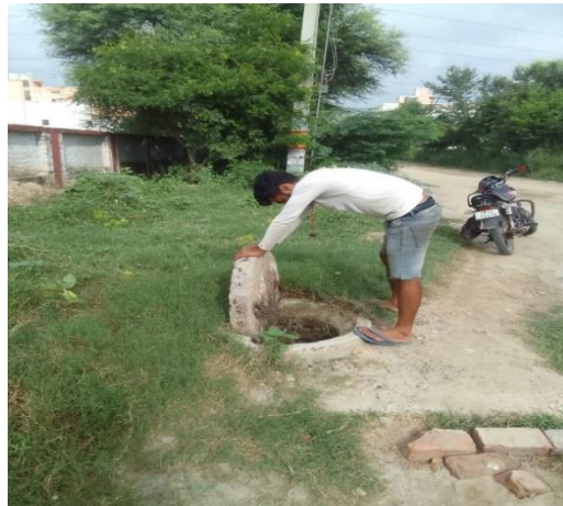
Effluent diversion chamber Phase-III
